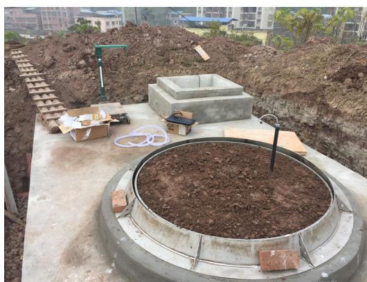
此蒸渗监测系统组成：地下室，蒸渗仪容器，称重单元，抽水系统，数据记录仪，一系列的土壤水分、温度、水势传感器。
