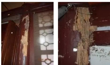
御书楼梁柱构架存在显著变形、腐朽、虫蛀
