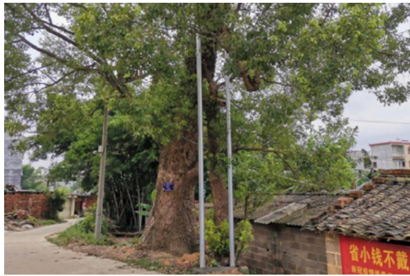
古樟树因腐朽树洞及长势倾斜“A”字型支撑
