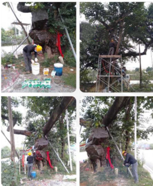
古树根部透气孔复壮作业
