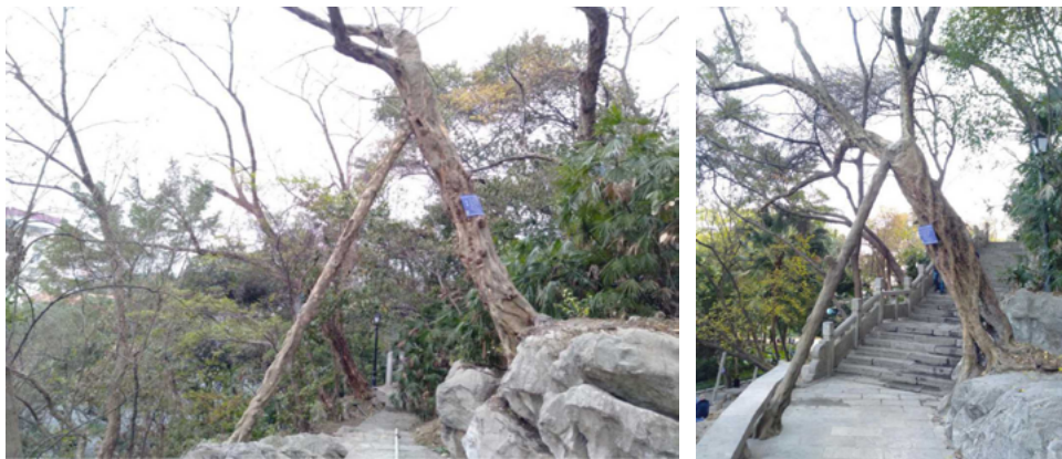
青檀古树长势倾斜修筑仿木支撑
