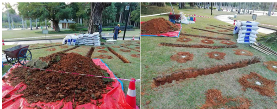
古树根部透气孔复壮作业
