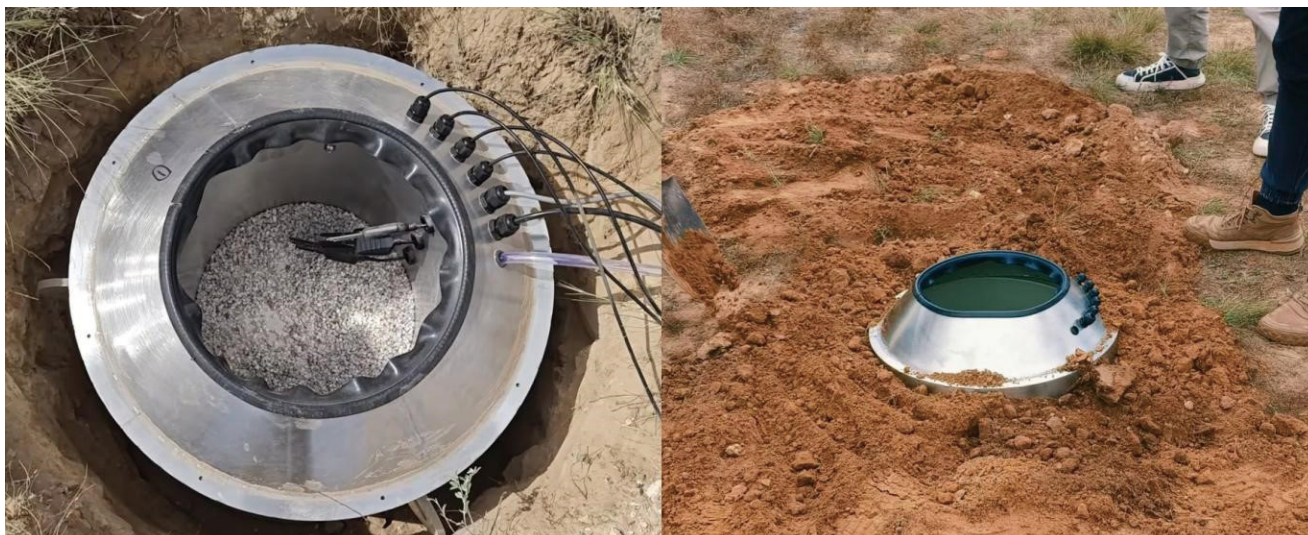
现场蒸渗桶安装、埋设与系统联调（点将科技现场照片）
